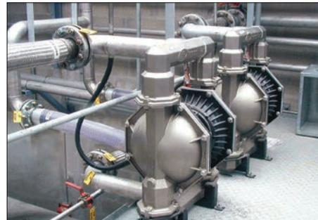
*Pompe a membrana da 3" in acciaio inox installate in un impianto di trasferimento di materiale solido*
