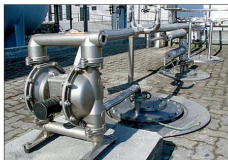
Pompa a membrana da 1 1/2" installata in un impianto di tipo chimico per il trasferimento di cloruro di metilene
