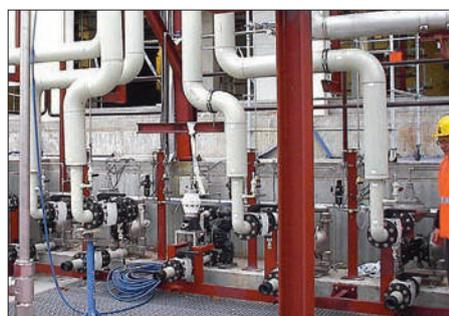
Pompe a membrana in acciaio inox da 2", assemblate con ammortizzatori di pulsazioni in PVDF, utilizzate per scaricare per scaricare acido fluoridrico
