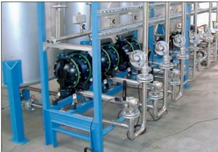
*Pompe a membrana da 1 1/2" in alluminio installate per alimentare un reattore chimico*
