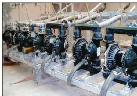
Pompe a membrana da 3" montate su una rampa per il trasferimento dell'argilla nella produzione della ceramica
